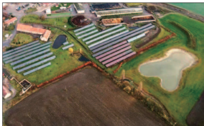
Obrázek č. 8: Revitalizace Lidušky II. etapa - objekt SO02 – lokalita Zdonín po realizaci
