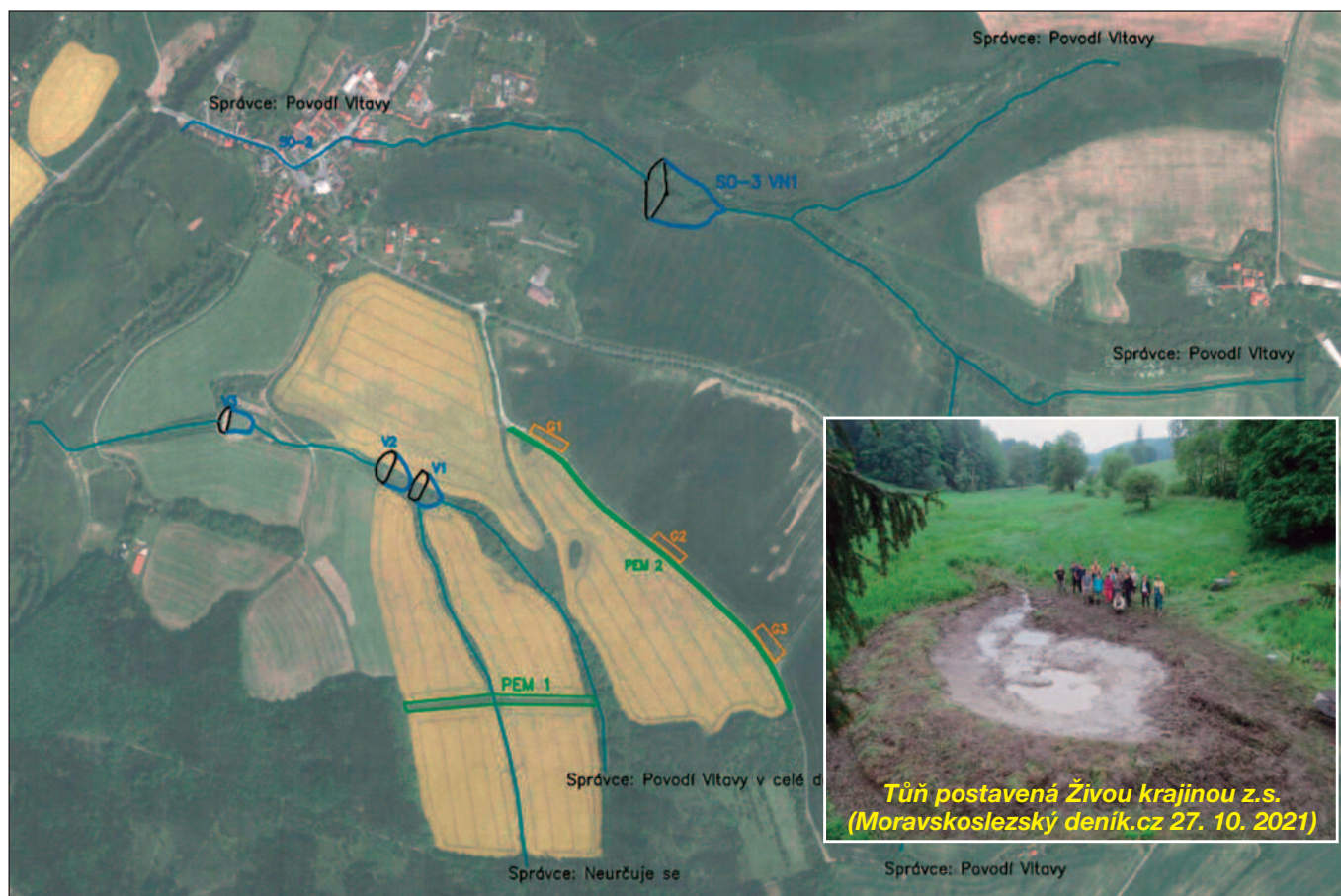
Příklad realizace komplexní pozemkové úpravy v dílčím povodí. Soustava třech malých vodních nádrží (v1, v2 a v3) postavené vlastníky nově vytvořených pozemků, malé vodní nádrže So – 3VN 1 postavené Státním pozemkovým úřadem na toku, který je ve správě Povodí Berounky a dále protierozní meze zasakovacího travního pásu a třech zasakovacích podzemních kontejnerů, také investice SPÚ (Předence, Plzeň jih, 2016)
